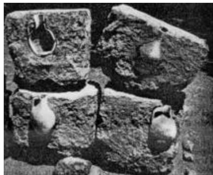
Figure 1 : Vases acoustiques encastrés dans des blocs de pierre.
